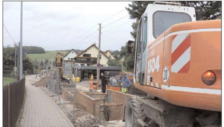
Die Hausanschlüsse waren mit vorbereitet bzw. schon bis über die Grundstücksgrenze verlegt. Im September konnte auf weiteren Abschnitten die Tragschicht und auch schon die mittlere, die Bindschicht, eingebaut werden. Anfang Oktober (09.10.2013) war der Graben bis zur Kurve vor der Haus Nr. 206 ausgehoben und damit der Zeitplan eingehalten.
