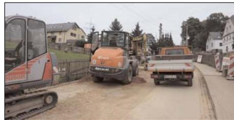
Für das letzte Stück wurden noch im Oktober die Rohre verlegt, der Graben wieder verfüllt und auch die einzelnen Asphaltsschichten eingebracht.
